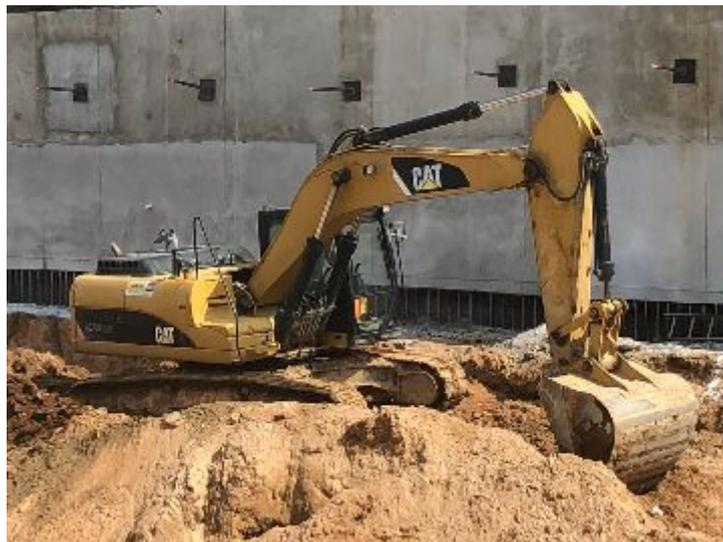
La excavadora trabaja en jornada regular de 7:00 a.m. a 5:00 p.m. realizando labores de corte y carga de material existente, utilizando un operador único. Regularmente se llena el tanque de combustible después de cada 2 o 3 jornadas y el jefe de maquinaria reporta la siguiente información:
