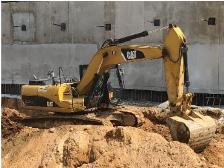
L'escavatore funziona regolarmente dalle 7:00 del mattino. alle 17:00 eseguire il taglio e il caricamento di materiale esistente, utilizzando un solo operatore. Il serbatoio del carburante viene riempito regolarmente ogni 2 o 3 giorni e il capo macchina segnala le seguenti informazioni:
